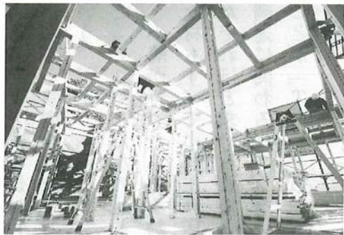
上棟建設中の「TOKYO WOOD」の家、価格は1棟2,500万円程度
