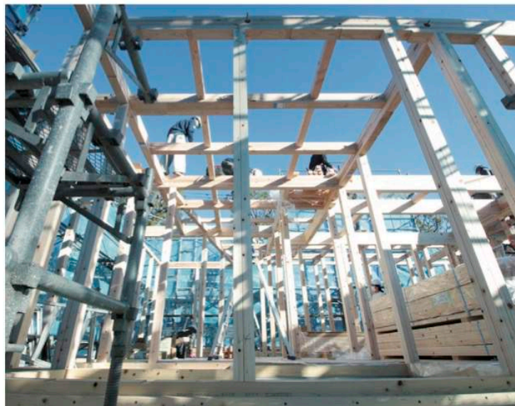
東京都産の高品質木材「TOKYO WOOD」を使った新しいモデルハウスの建設が小金井市内で進んでいる。(関連記事p13参照)
