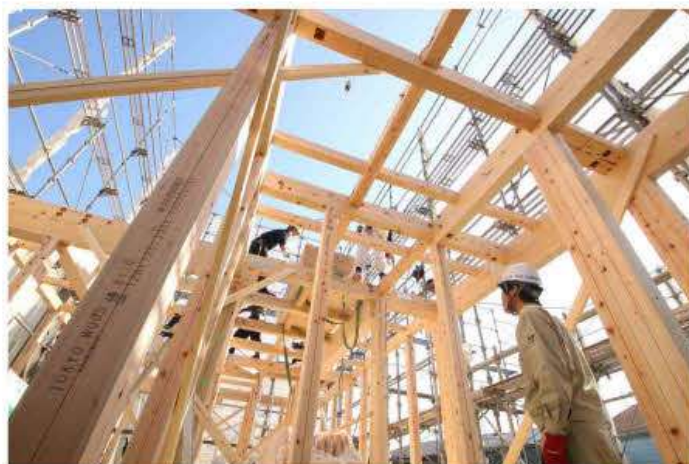
上棟現場 TOKYO WOODの構造材
