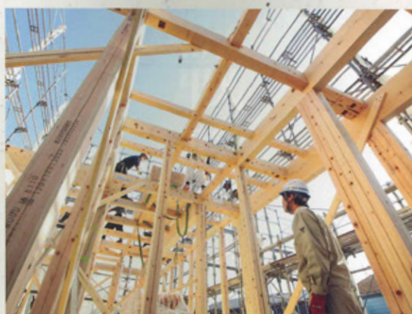
良質な木材を職人たちが丁寧に扱い、心を込めて組み立てていく*
